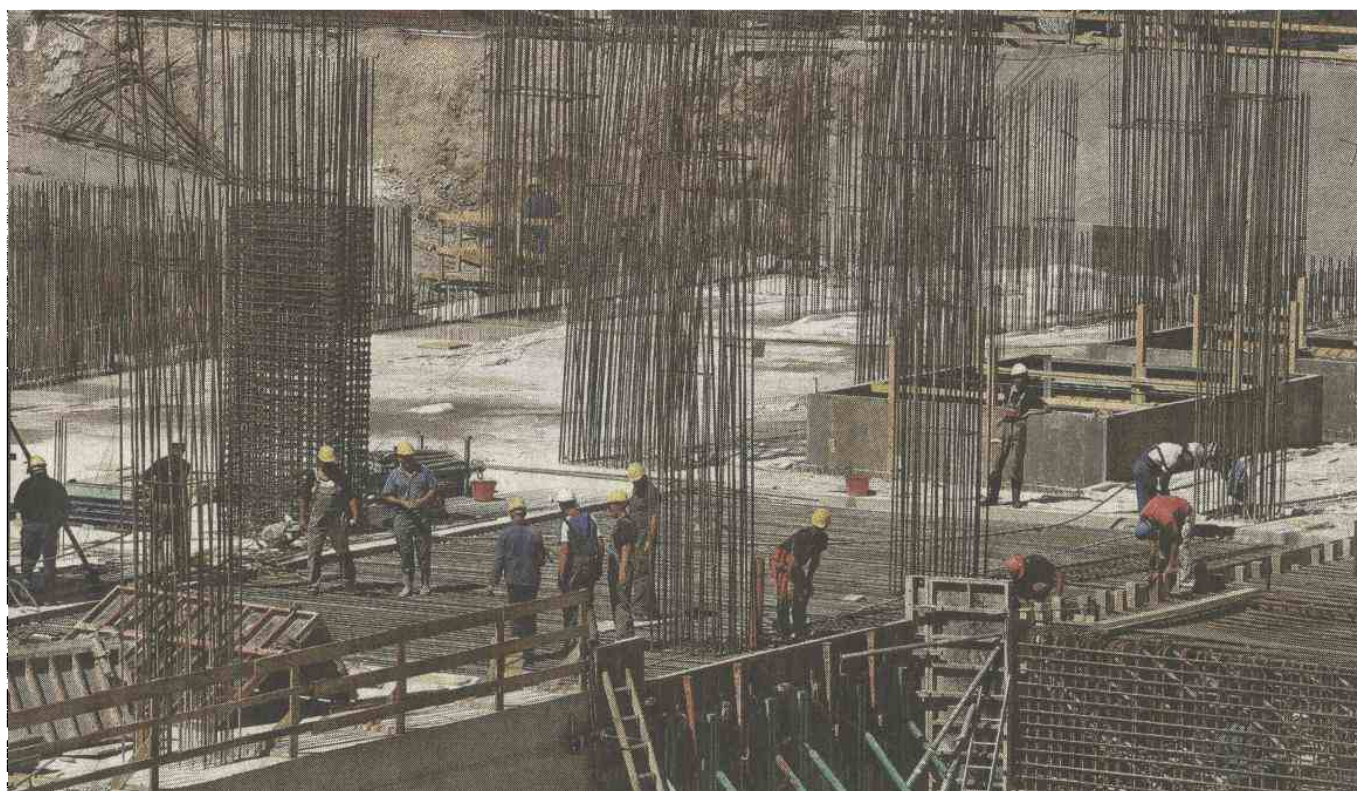
GRADBIŠČE ŠESTEGA BLOKA TERMoeLEKTRARNE ŠOŠTANJ FOTO ALEŠ ČERNIVEC/DOKUMENTACIJA DELA
