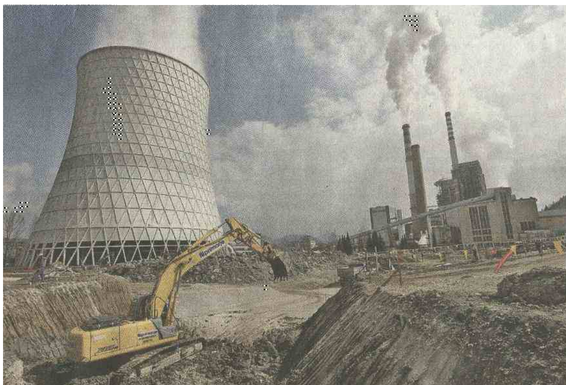
GRADBIŠČE ŠESTEGA BLOKA TERMOELEKTRARNE SOŠTANJ – Očitki letijo v vse smeri.
